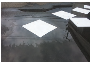
● 流出した油の回収作業
