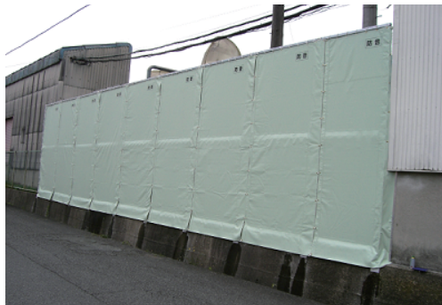
▲W16,000×H3,500 ※写真はシート張り込み施工
